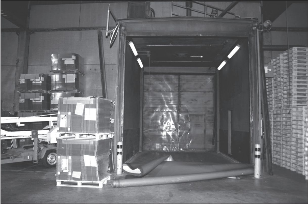
Kuva 1. Paperitehtaan alas pudonnut nostorullaovi. NN ja MM työskentelivät oviaukon vasemmalla puolella.
