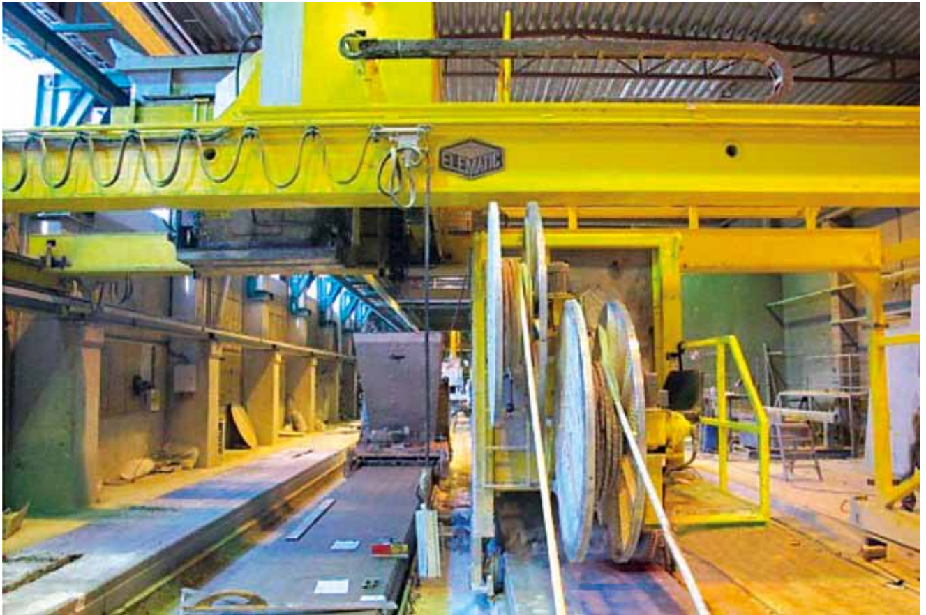
Kuva 1. Kuvassa vasemmalla on valettava ontelolaatta, oikealla sahausyksikkö ja niiden päällä välikuljettimen vaakapalkki.
