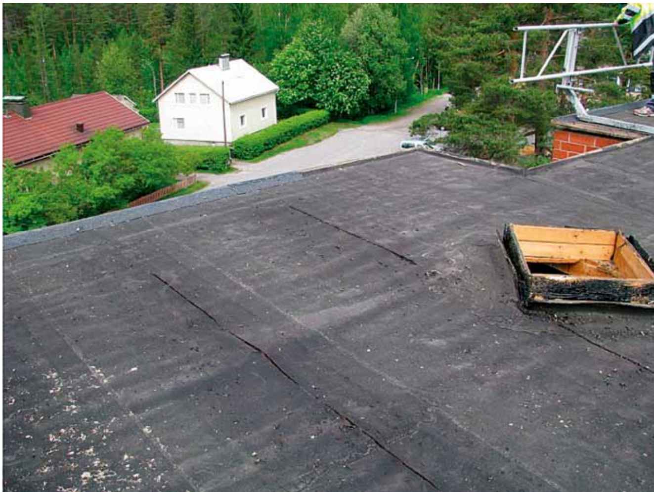
Kuva 3. NN oli vetänyt bitumileikkuria selkä edellä taustalla olevaa porrassyvennystä kohti ja pudonnut syvennyksen kohdalla maahan. Taustalla näkyy asennetun vastapainokaiteen pää. Kuvassa olevan läpiviennin reunukset ja aukko estivät tapaturmahetkellä leikkurin työntämisen.
