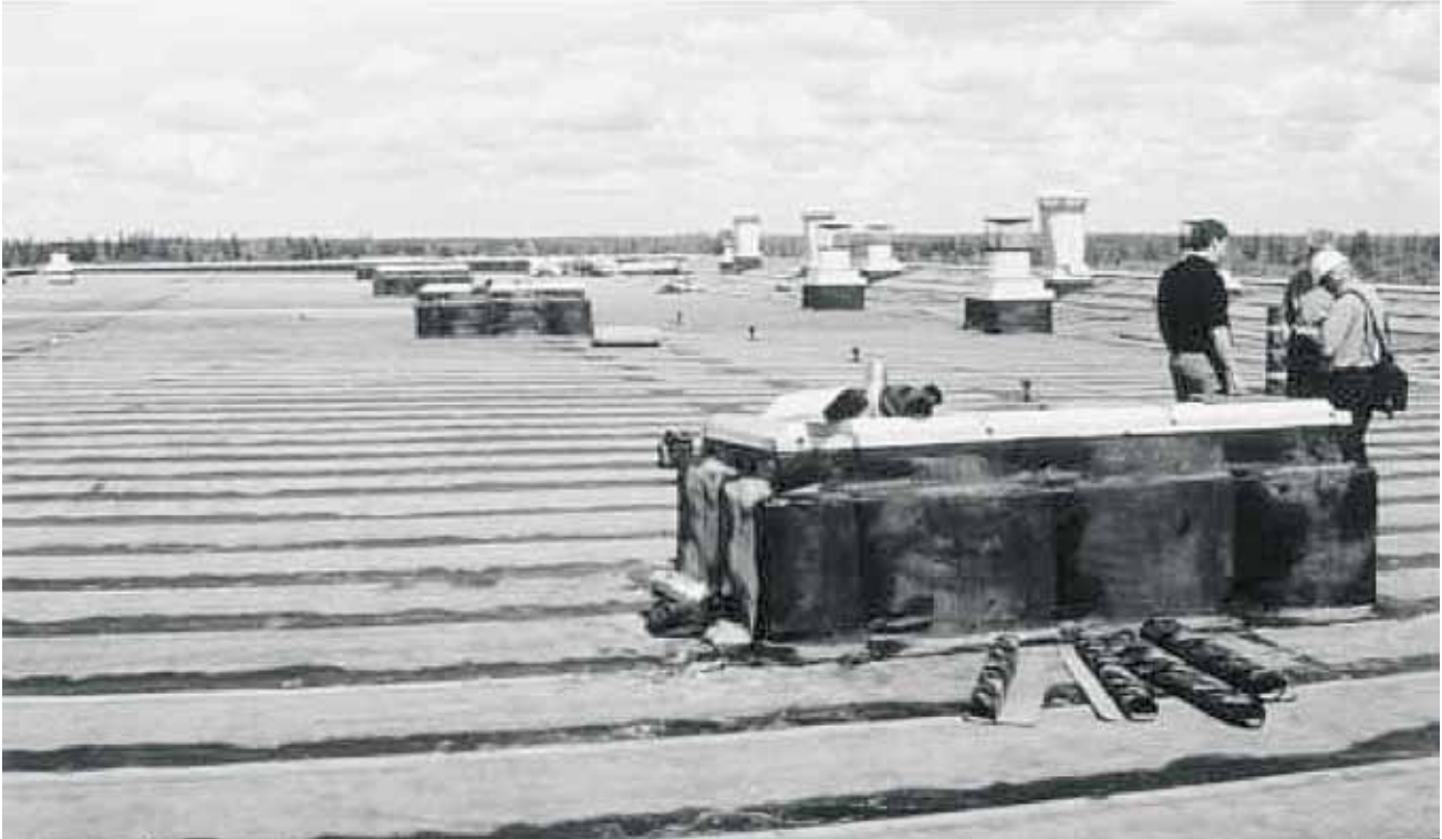
Kuva 1. Teollisuuslaitoksen katolla sijainneet savunpoistohormit, jollaisten päällä istuttiin taukojen aikana.
