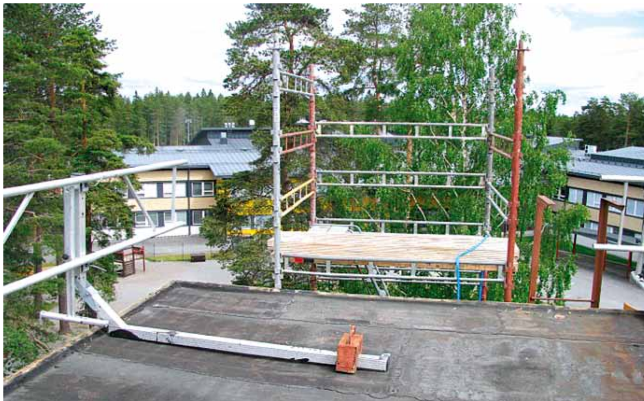
Kuva 1. Katolle rakennetun porrastornin yläosa ja pystytettyjä vastapainokaiteita.
