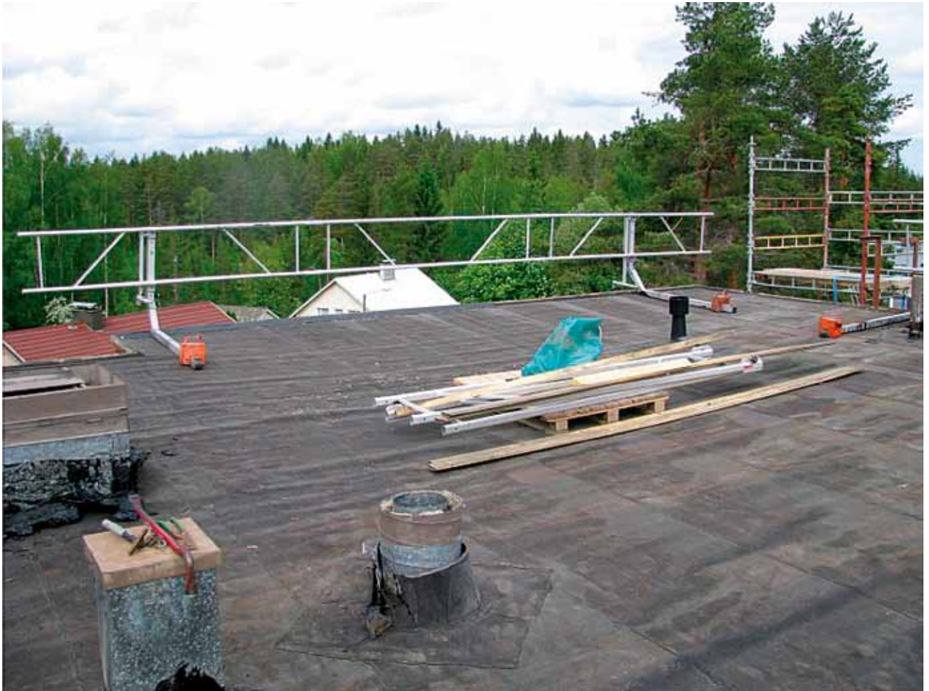
Kuva 2. Yleiskuva katolla olevista tarvikkeista ja kaiteista.
