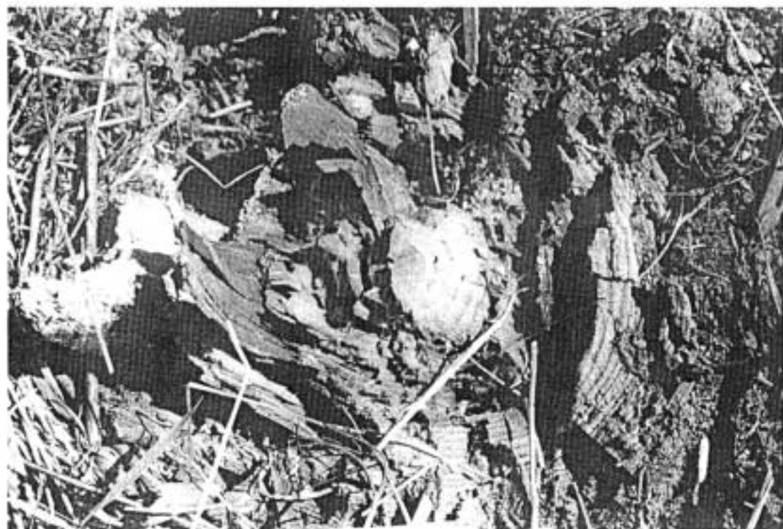
Kuva 2. Pylvään kanto tapaturman jälkeen.
