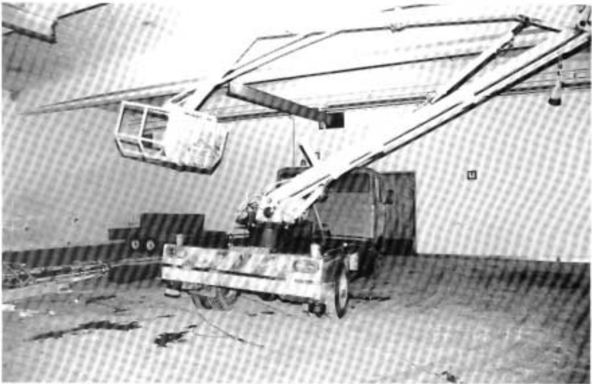
Kuva 1. Nostolaite tapaturman sattumisen jälkeen. Katossa kohta, mistä kiskonpätkä on leikattu pois.
