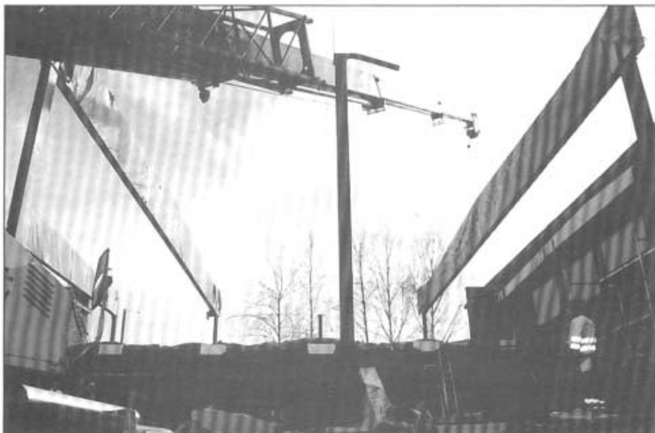
Kuva 3. Nosturin puomi. Keskellä tuet, joilta palkki putosi.
