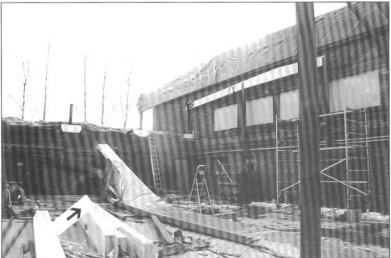
Kuva 2. Alas pudonnut palkki, joka osui N.N:ään. Nuoli osoittaa tapahtumapaikkaa.
