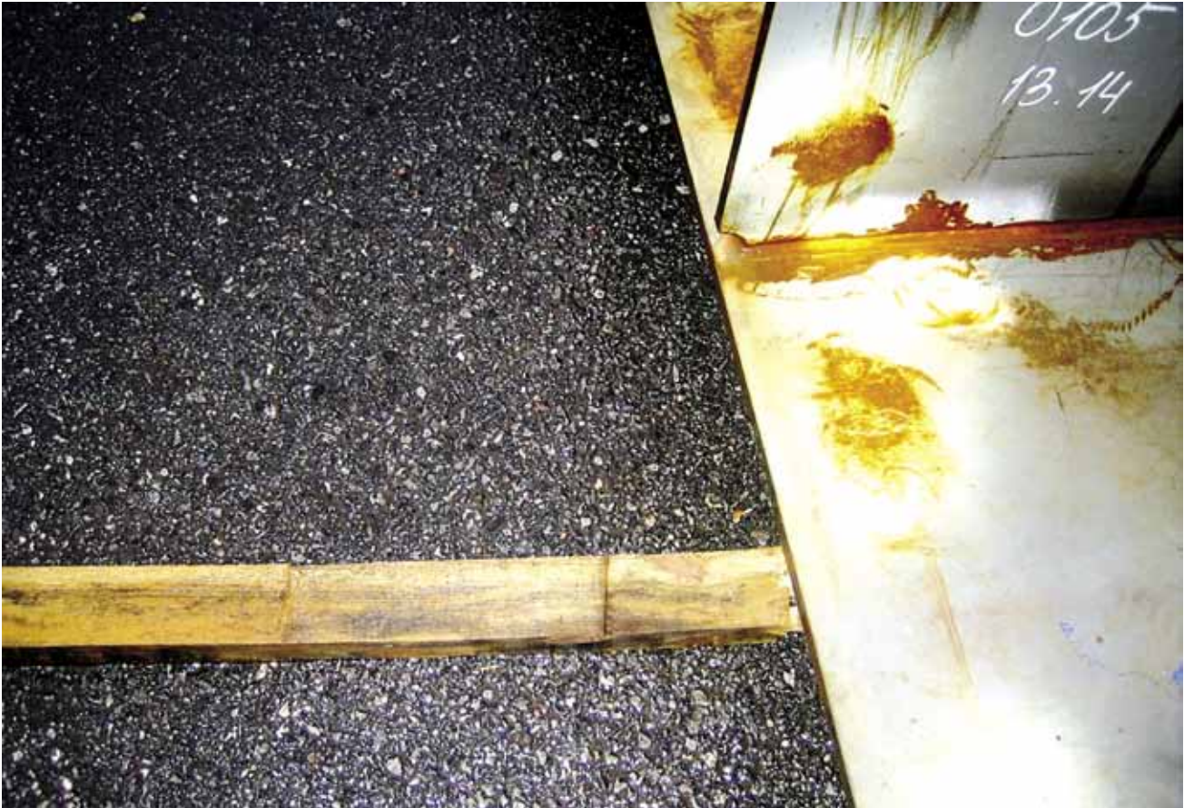
Kuva 3. Palkin alle asetettu aluspuu, joka on puristunut suuren painon alla.
