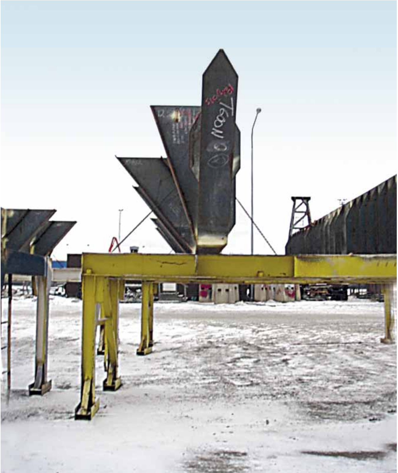
Kuva 1. Vastaavanlainen palkki varastoalueella merikuljetusasennossa.
