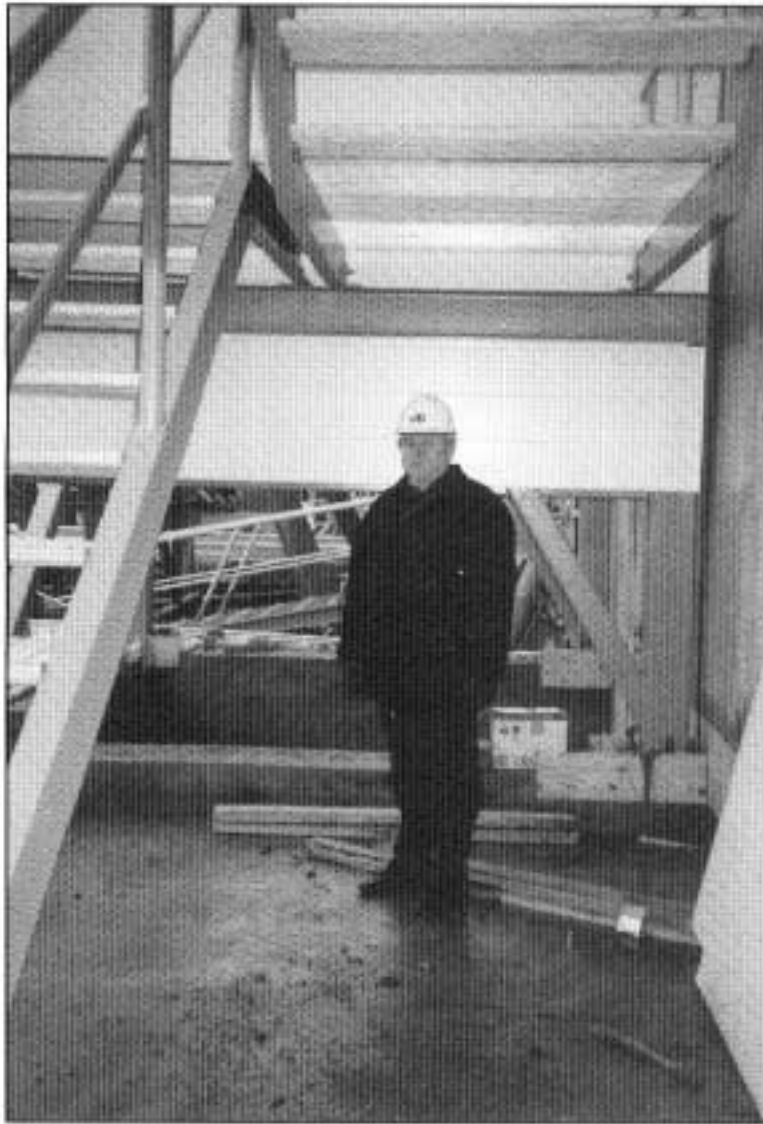
Kuva 3. Onnettomuudessa mukana ollut elementti lopullisessa kiinnityskohdassaan.
