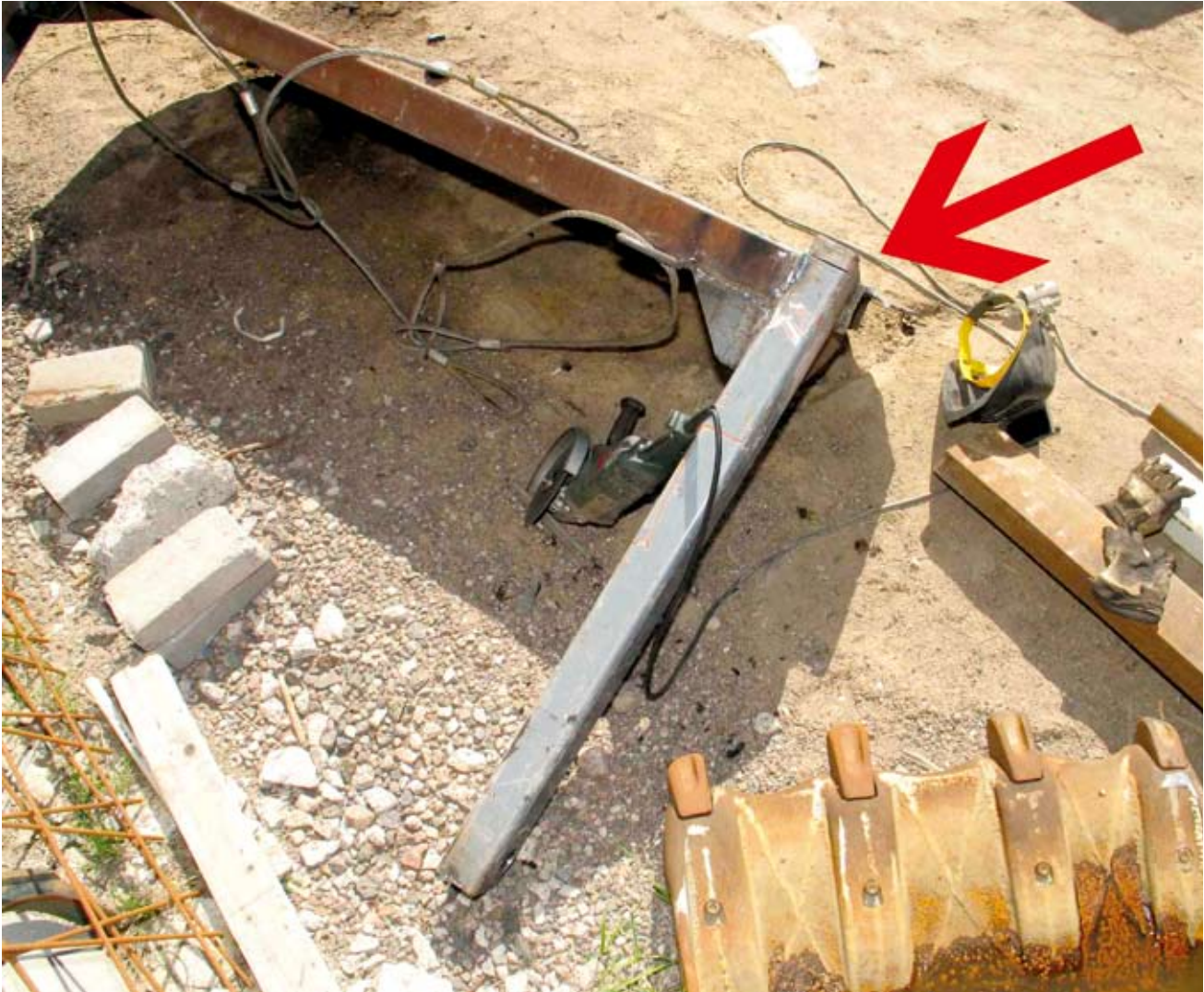
Kuva 1. Kuva NN:n työskentelypaikasta tapaturman jälkeen. Nuoli osoittaa leikkauskohtaa. Kuvassa näkyy rälläkkä, maski, rukkaset, suorakulma, mitta, sytytin sekä pieniä kappaleita palaneista vaatteista.
