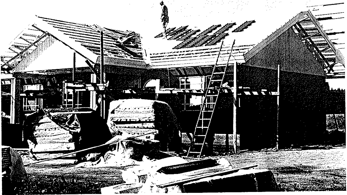
Valmisteilla oleva talo sulvalla Katolle seisova mies on sillalla paikalla, mistä NN oli pudonnut ketterimoituksen läpi.
