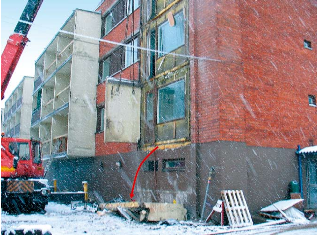
Kuva 1. Leikattuaan parvekkeen sivuseinät irti parvekkeen alalaatta taittui rakennuksen ulkoseinästä saranana alaspäin, jolloin NN putosi maahan.
