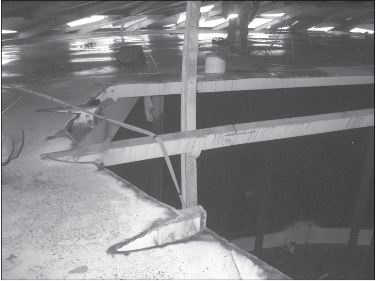
Kuva 5. NN:n käyttämät ja aukosta alaspudonneet kaasuletkut tapaturman jälkeen.
