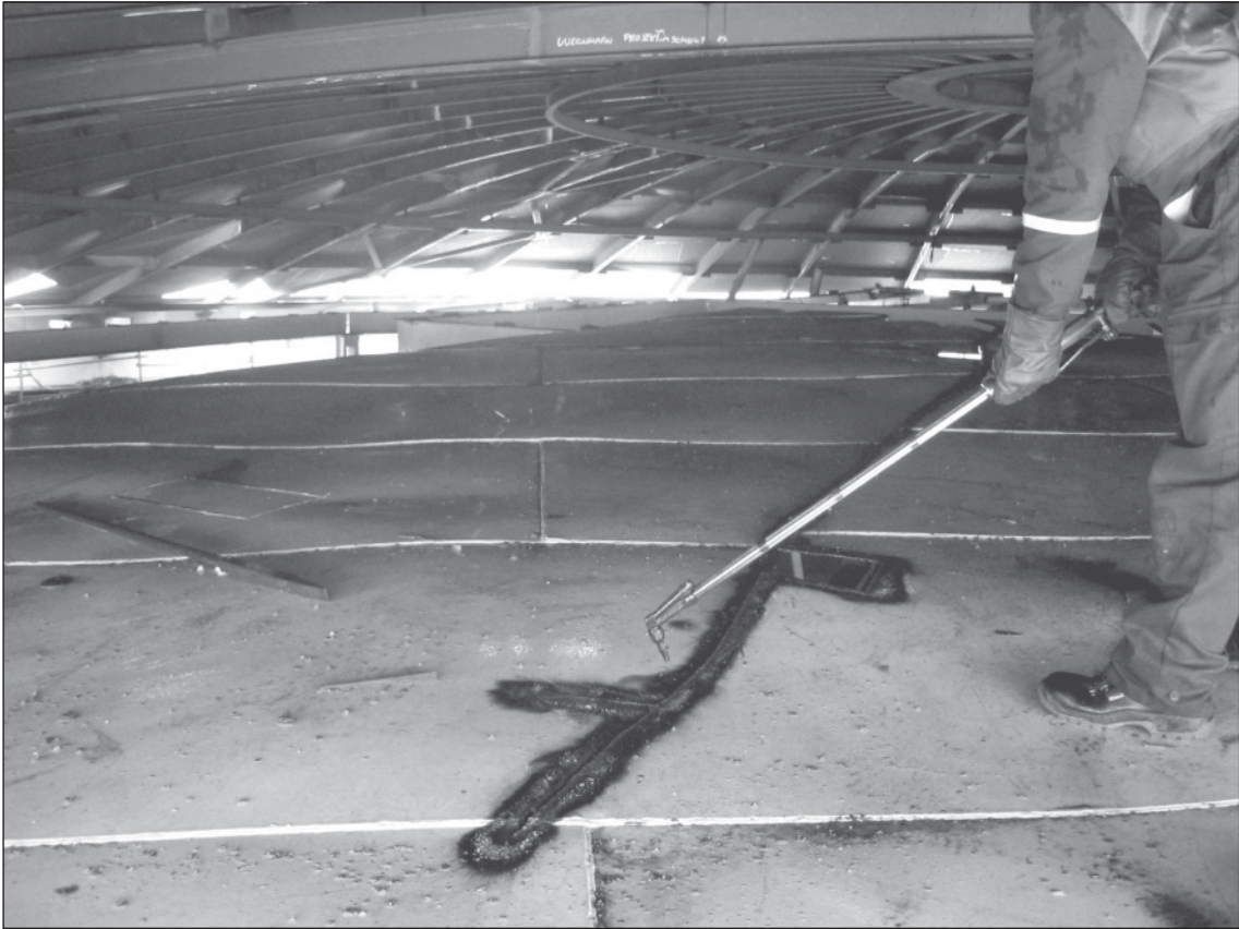
Kuva 1. Työtapa, jolla kattoa polttoleikattiin.
