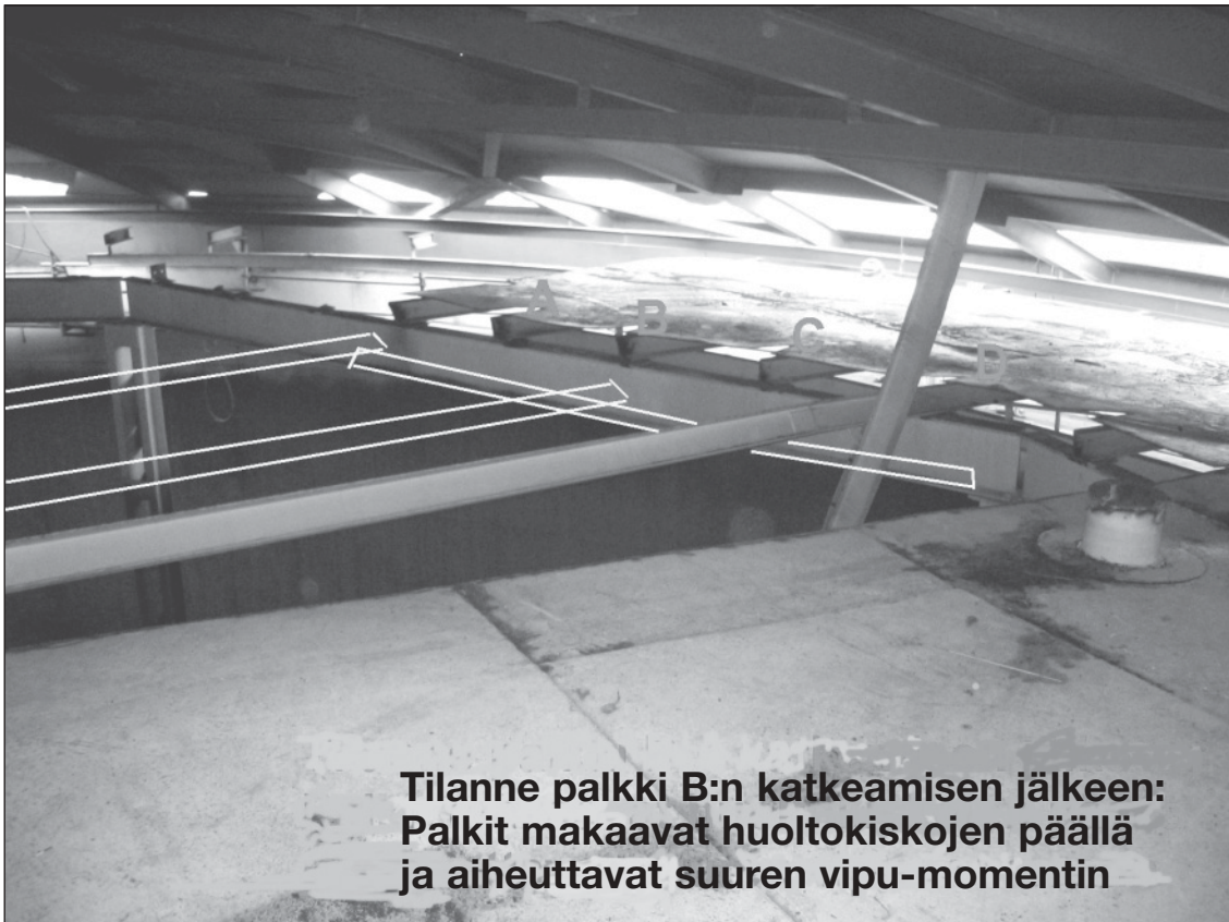
Kuva 3. Tilanne sen jälkeen kun NN oli katkaissut kuvassa olevalta kohdalta palkin B. Pystyssä oleva palkki on maalausaisko, jota NN ei ollut katkaissut.
