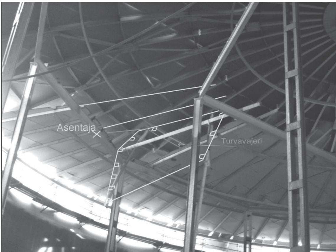
Kuva 2. Kuva alhaaltapäin. Kuvaan on piirretty irtileikattu levy sekä NN:n ja turvavajerin sijainnit tapaturmahetkellä.
