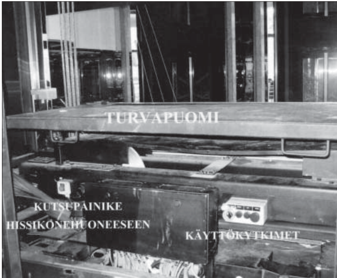
Kuva 3. Hissikorin yläosa. Turvapuomi on ala-asennossa. Oikealla alhaalla on käyttökytkinpaneeli. Oikeanpuoleisin kytkin on hätäpysäytin, johon NN ehkä yritti kurtottaa.
