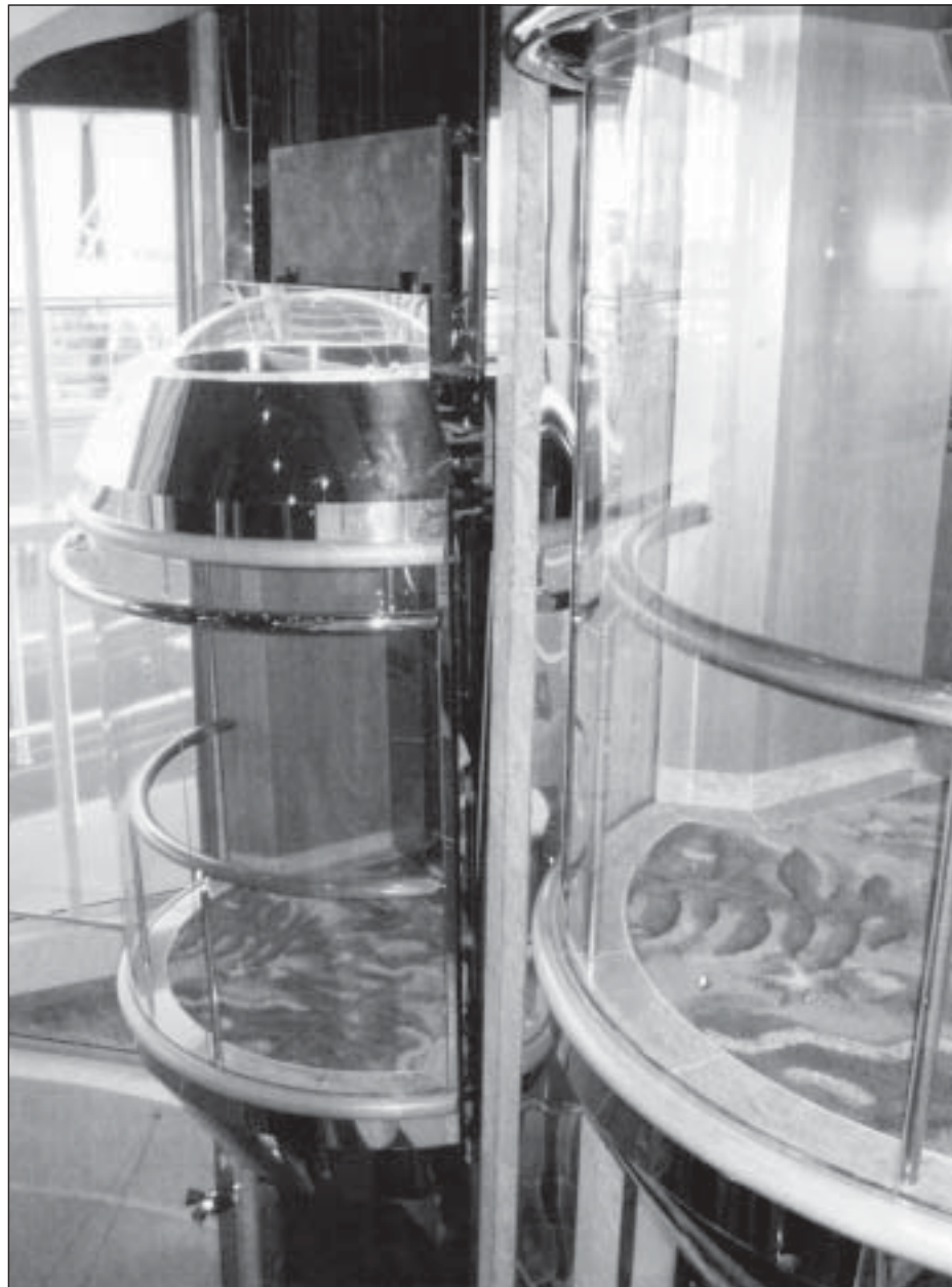
Kuva 1. Maisemahissin sijainti tapaturman jälkeen. Turvapuomi (levy hissin päällä) on tässä tapauksessa nostettu yläasentoon. Hissin kori oli yläpäästään siirtynyt n. 10 cm ulospäin (kuvassa vasemmalle päin).
