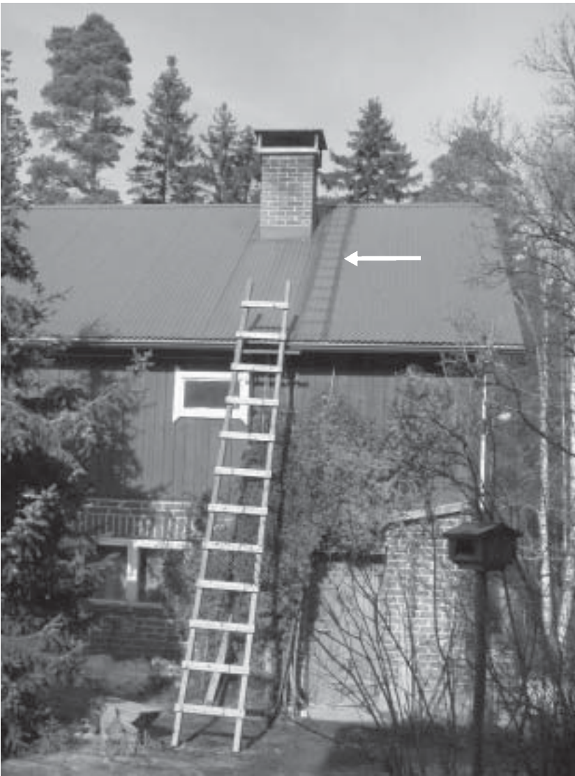
Kuva 1. Yleiskuva tapahtumapaikalta. Nojatikkaat ovat samalla paikalla kuin tapahtumahetkellä. Lapetikkaiden paikka näkyy tummina jälkinä katossa (nuoli).
