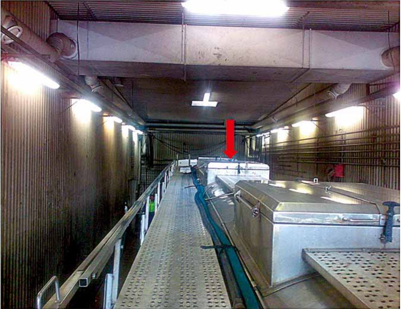
Kuva 1. Näkymä säiliön päältä. Löytäessään NN:n huoltomiehet näkivät NN:n makaavan ma-hallaan säiliön päällä, auton etuosasta laskettuna toisen säiliöluukun päällä (punainen nuoli), kasvot kohti auton keulaa. Hänen vasen jalkansa oli nivuseen asti säiliön sisällä.
