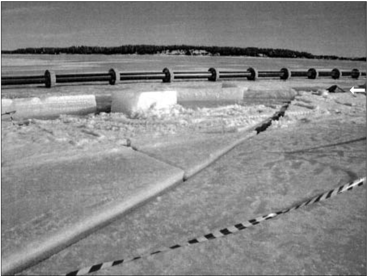
Kuva 1. Kuva railosta, kaivinkoneen uppoamiskohdasta. Kaivinkoneesta näkyvissä osa puomia. (Nuoli osoittaa puomia)
