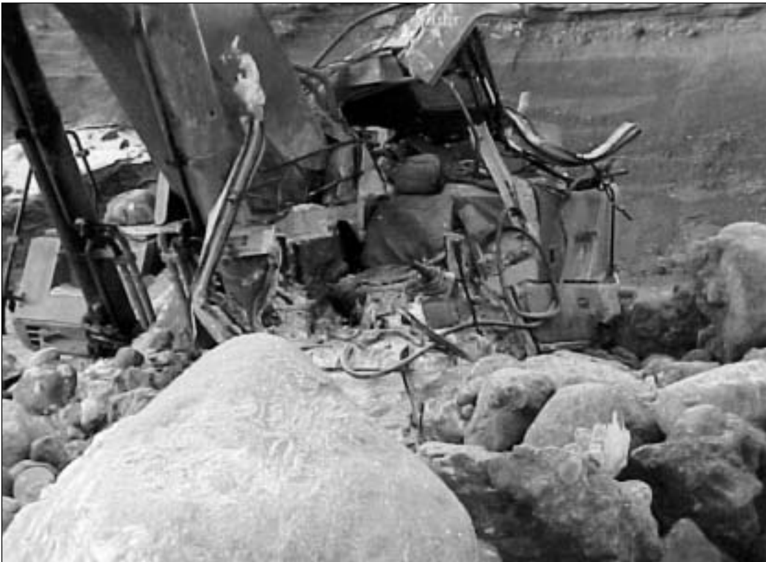
Kuva 2. Kaivinkoneen ohjaamo leikattuna auki pelastusyksikön toimesta.
