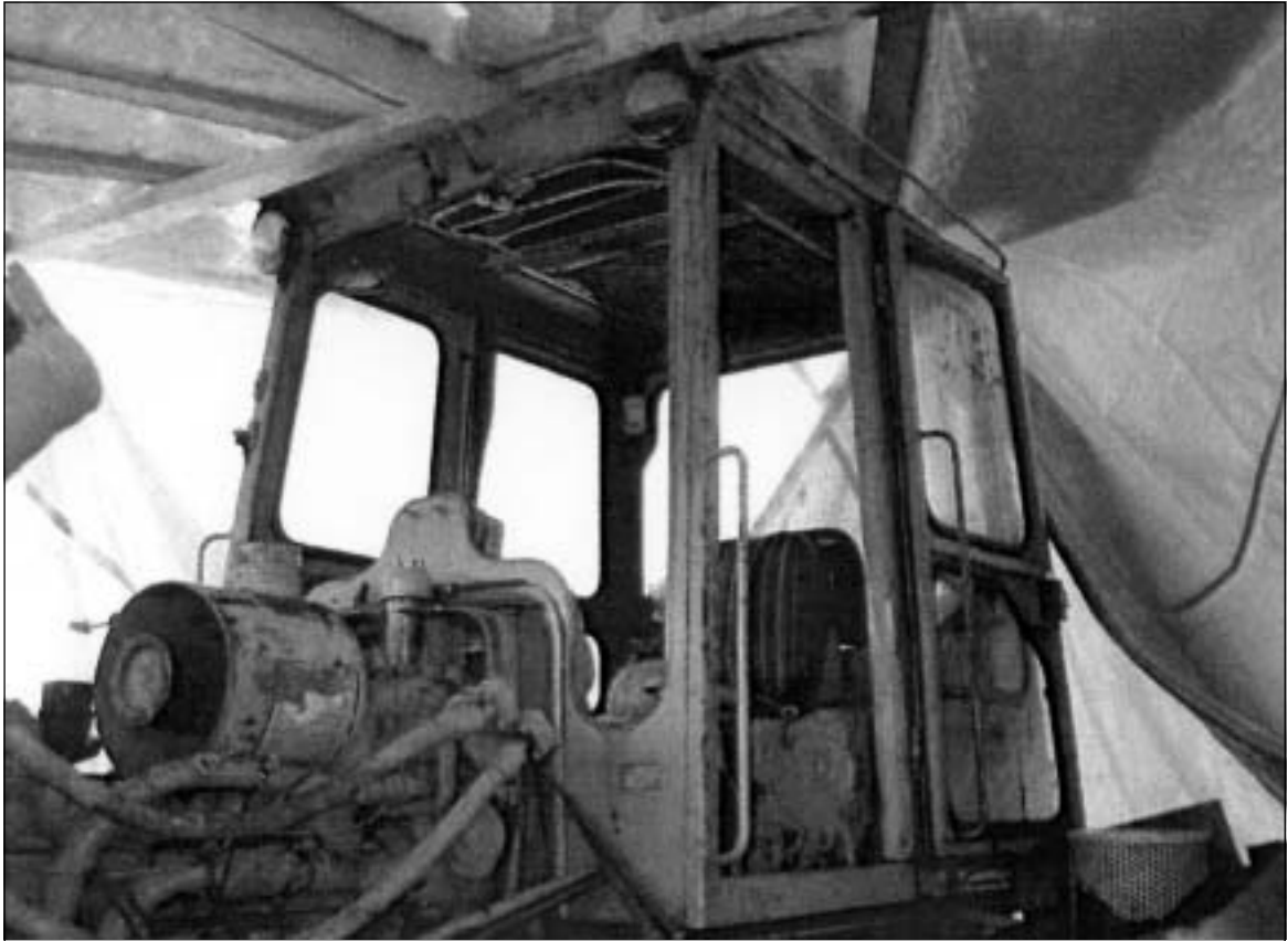
Kuva 3. Kone ylösnoston jälkeen, ei kattoluukkaa.
