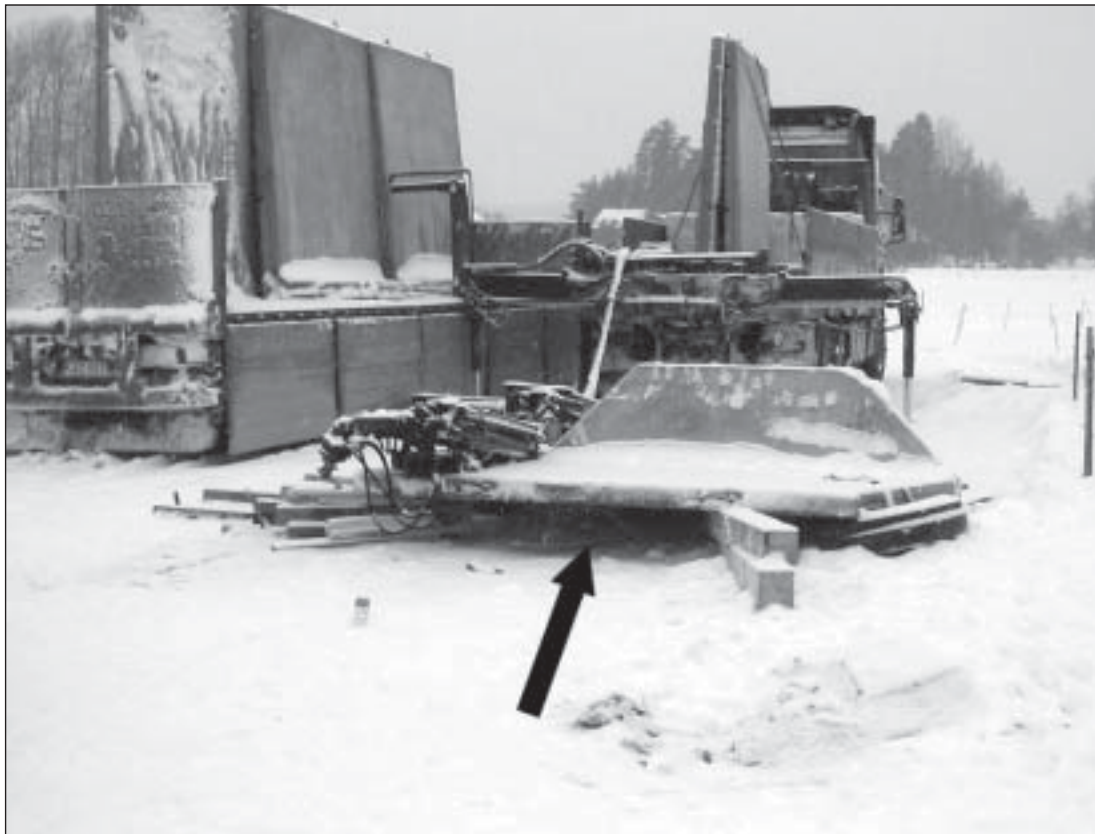
Kuva 1. Yleiskuva tapahtumapaikalta. Nuoli osoittaa NN:n sijaintia. Elementti on tuettu lankuilla tapahtuman jälkeen.
