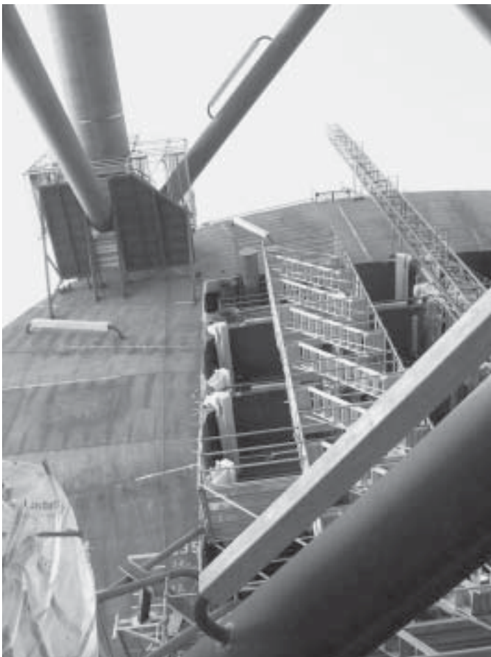
Kuva 4. Kuva maasta, jossa NN:n työtoverit odottivat hänen heittävän narun alas. NN jäi kuvassa keskellä ylhäällä ja telineen vasemmalla puolella olevan putken ruhjomaksi. Teline on hätäpoistumistie.
