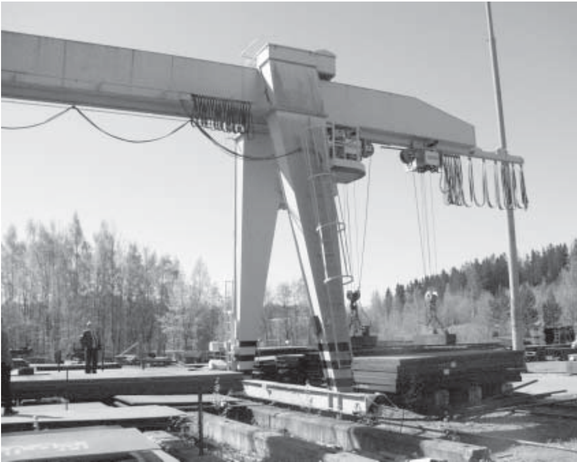
Kuva 1. Yleiskuva pukkinosturista ja varastoalueesta.
