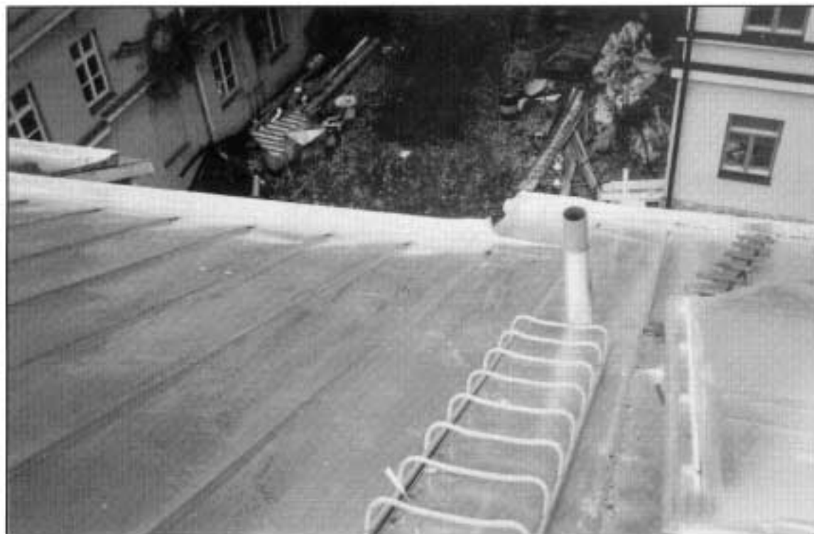
Kuva 3. Lapetikkaat, oikealla yhdet "kanatikkaat" ja kattoikkuna.
