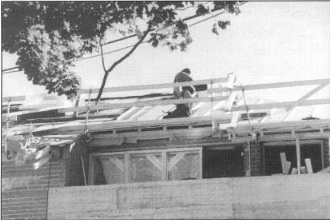
Kuva 1. Kattoitus pehitystyön aikana.
