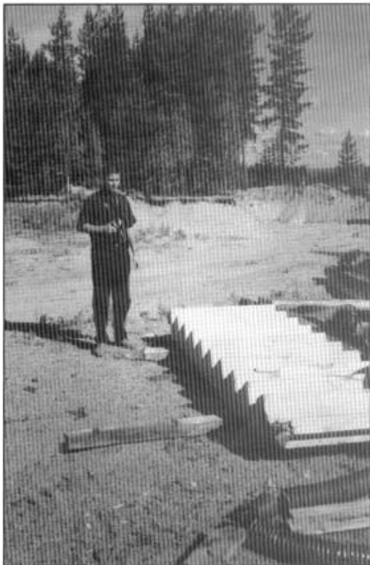
Kuva 2. Nostettu porraselementti.
