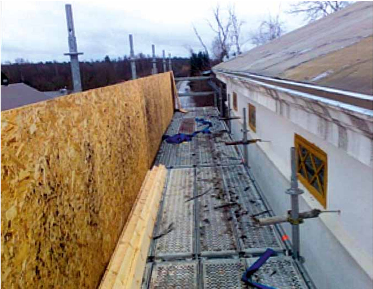
Kuva 3. NN ja MM olivat nousseet telineelle sen toisessa päässä olleet suojalevyt irrottamalla
