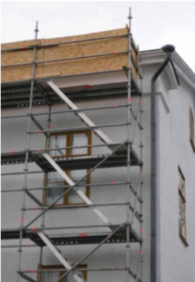
Kuva 2. Museorakennuksen kadun puoleiselle sivulle oli pystytetyt rakennustelineet, jotka olivat tapaturmakohdassa n. metrin lyhyemmät kuin räystään reuna.
