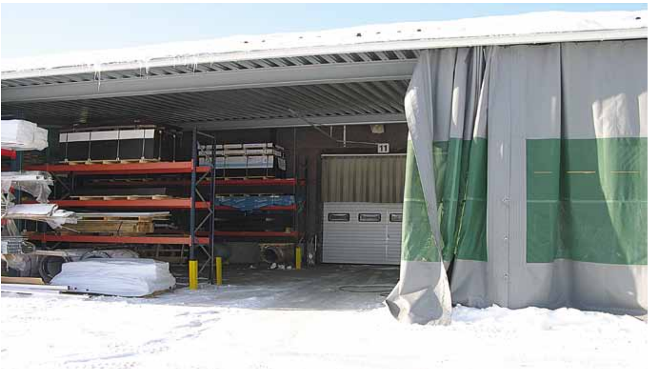
Kuva 2. Yleiskuva tapaturman sattumispaikasta. Kuva on otettu huomattavasti tapaturmaa myöhemmin.
