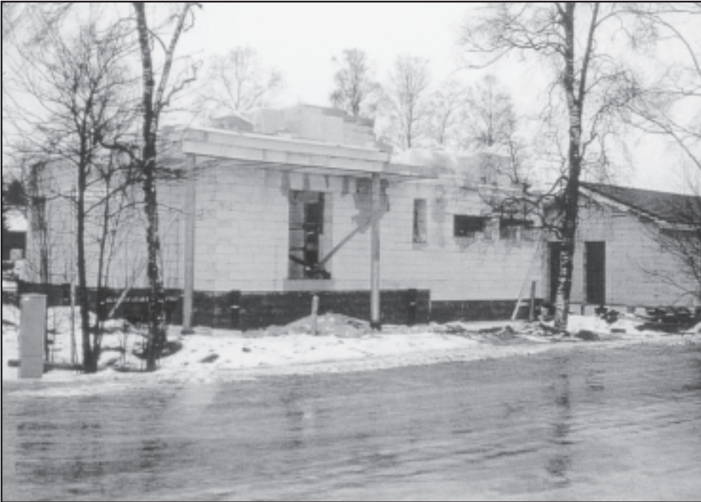
Kuva 1. Omakotitalon rakennustyömaa tien suunnasta.
