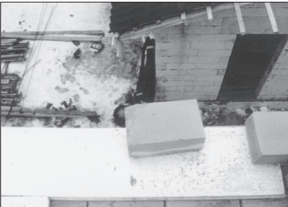
Kuva 2. Kuvassa näkymä holvilta autokatoksen suuntaan. NN putosi holvilta noin 3,9 metrin korkeudelta jäiseen maahan kuvassa näkyvien kevytbetoniharkkojen kohdalta.
