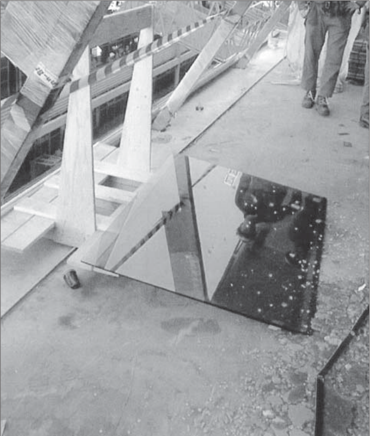
Kuva 3. Kuljetus- ja nostoteline. Kaksi sisälaivan puolelle telineeseen jäänyttä lasia kaatui kannelle.
