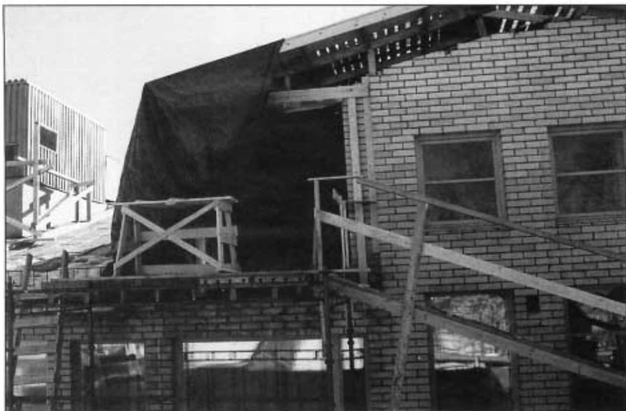
Kuva 1. Yleiskuva rakennustyömaasta ilmastointikonehuoneen kohdalta.
