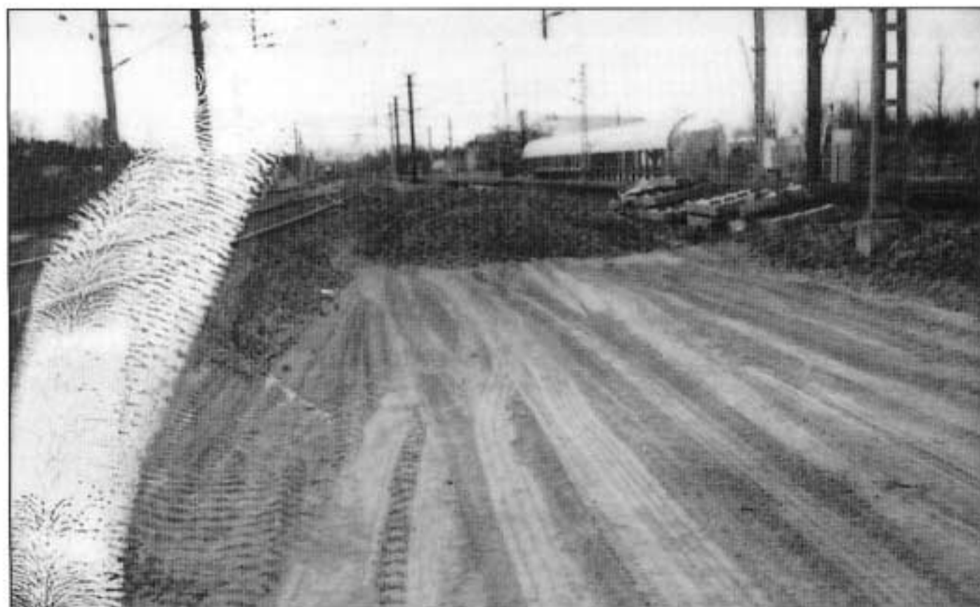
Kuvat 1 ja 2. Raitteiden väli, perustusreitti.
