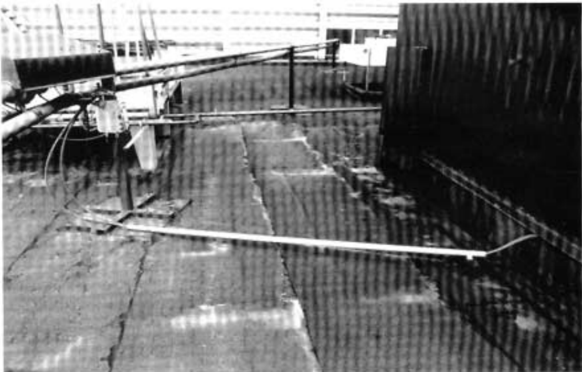
Kuva 4. Paineilmaletkut vesikatolla.
