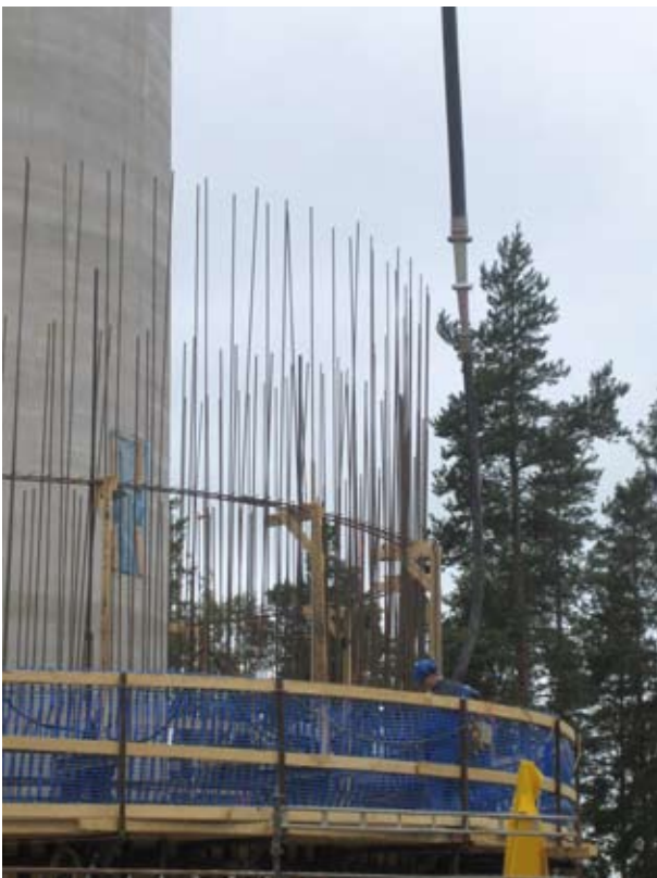
Kuva 2. Vastaavan kaltainen työskentelytaso ja raudoitus ohjureineen. (Kuvan työmaa ei liity tapaturmaan. Kuvassa työskentelytasoa kiertää erilainen tiheäilmäinen suojakaide kuin tapaturmapaikalla.)
