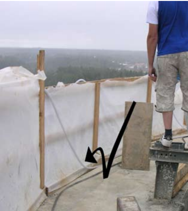
Kuva 5. Lavastettu kuva liukuvalumuotin työkentelytasolta. Pajavasara oli tarkoitus pudottaa työtasolle. Nuoli kuvaa pajavasaran mahdollista putoamisreittiä.
