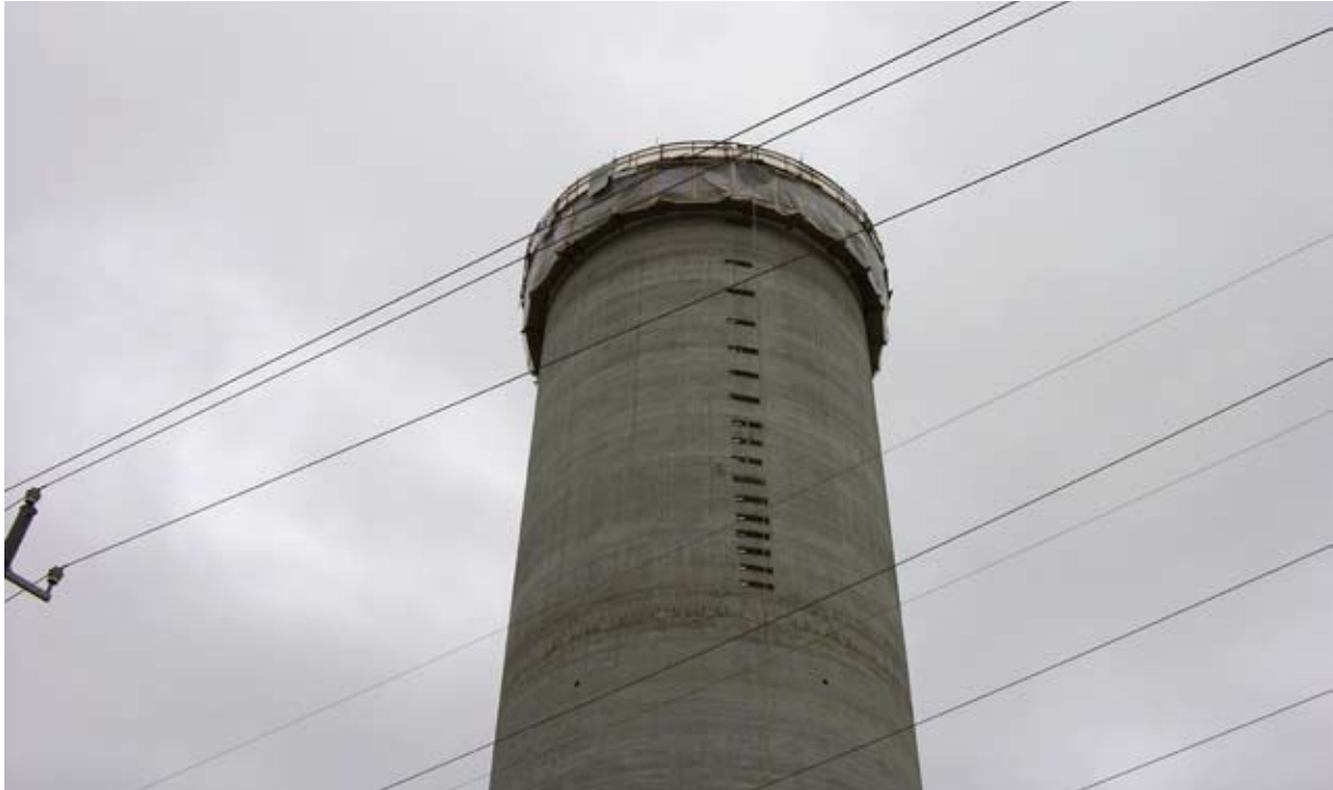
Kuva 1. 50 m korkea vesitorni, jonka huipulla on liukuvalumuotti työskentelytasoinen.
