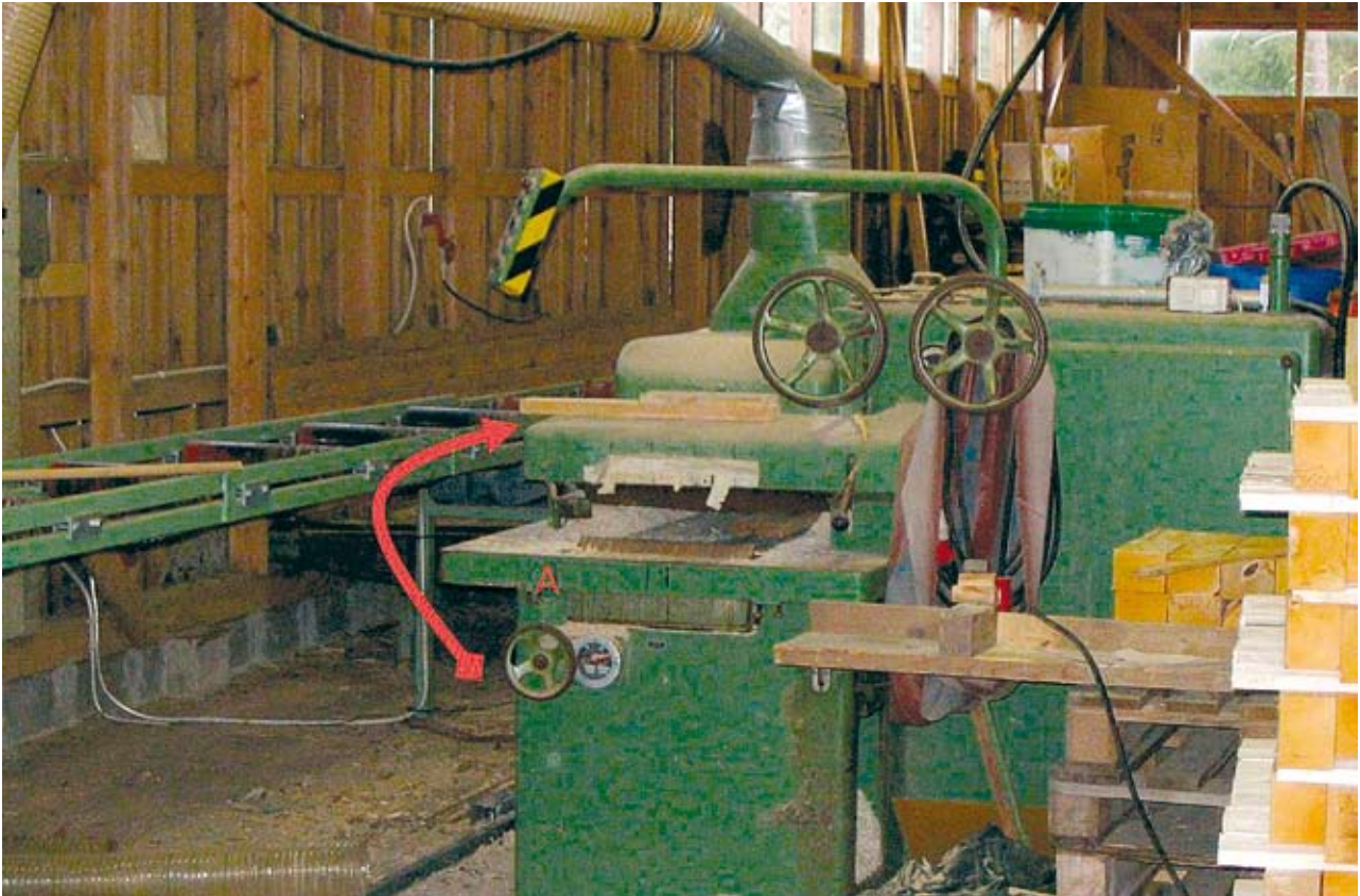
Kuva 1. Kuva sahan käyttöpaikalta (A). Todennäköisesti NN havaitsi edellisen soiron sahauksen osalta ongelmia, joita meni selvittämään sahan output -puolelle, ts. päättyyn, josta sahatut rimat tulevat ulos koneesta ja putoavat kuljettimelle.
