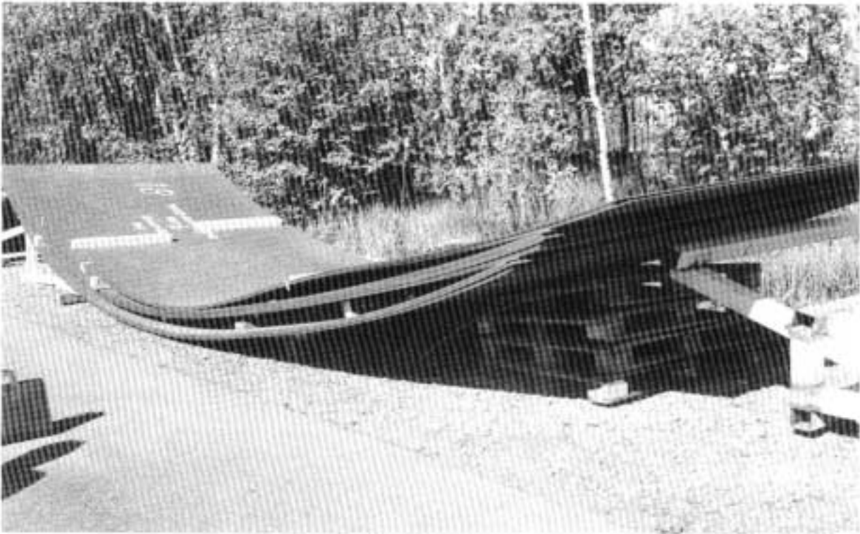
KUVA 1. Kaarevia levynippuja autosta maahan nostettuna.
