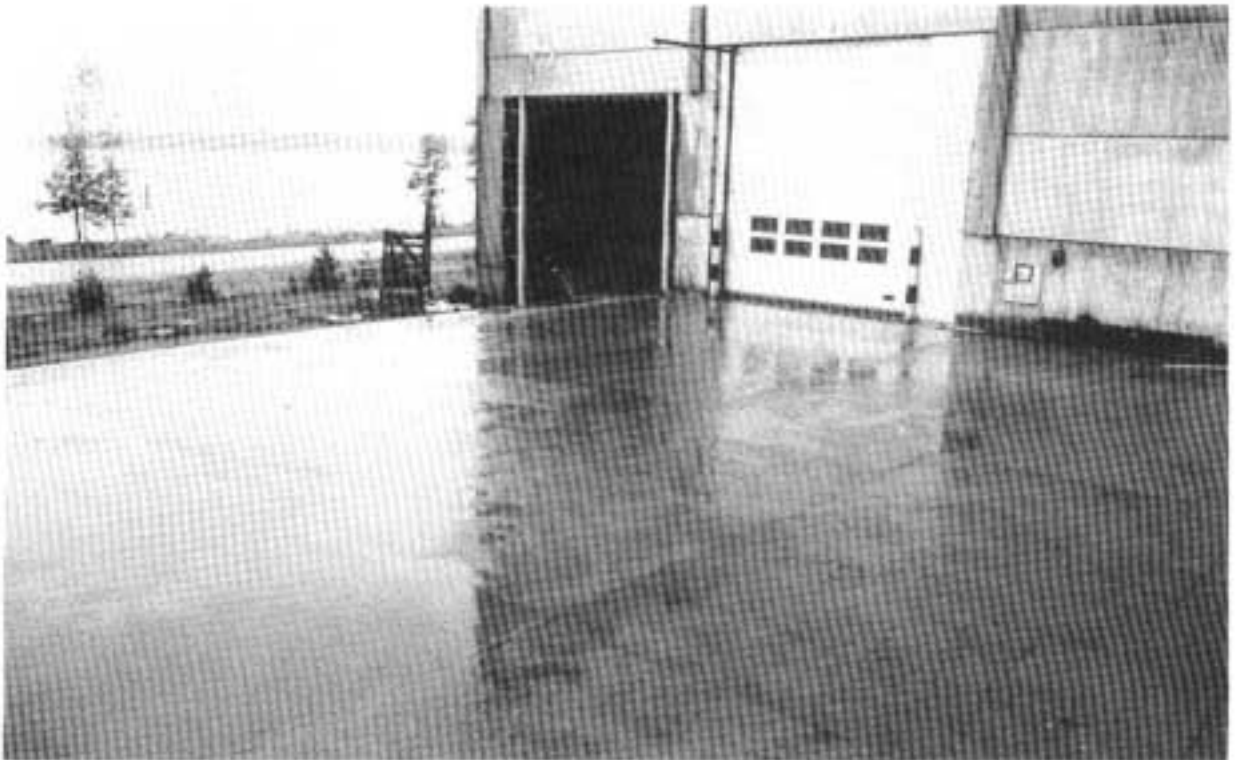
Kuva 1. Keskellä paperirullavaraston ovi, vasemmalla junan kulkuaukko.
