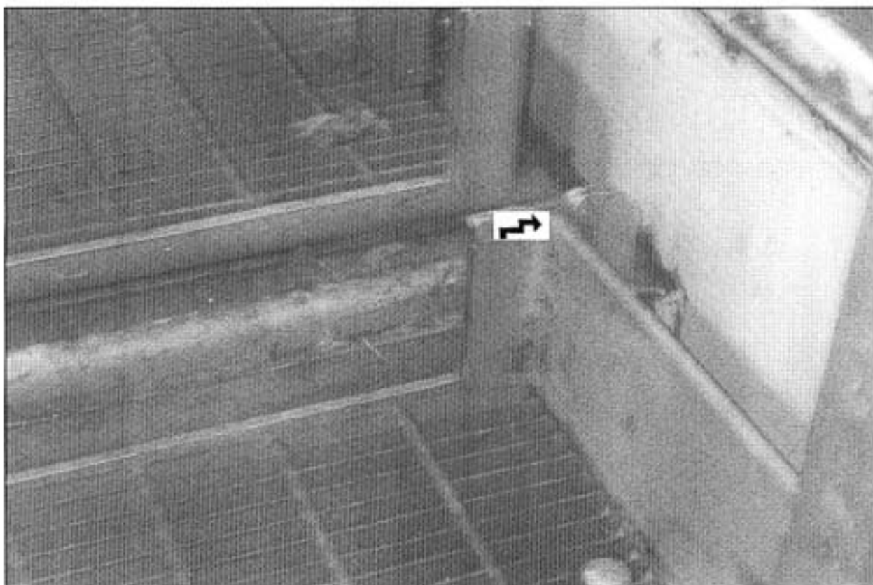
Kuva 4. Lähikuva märän pään puoleisesta kulkusillan kiinnityssalvasta (nuoli). Kuivan pään puolella on vastaava kiinnityssalpa.
