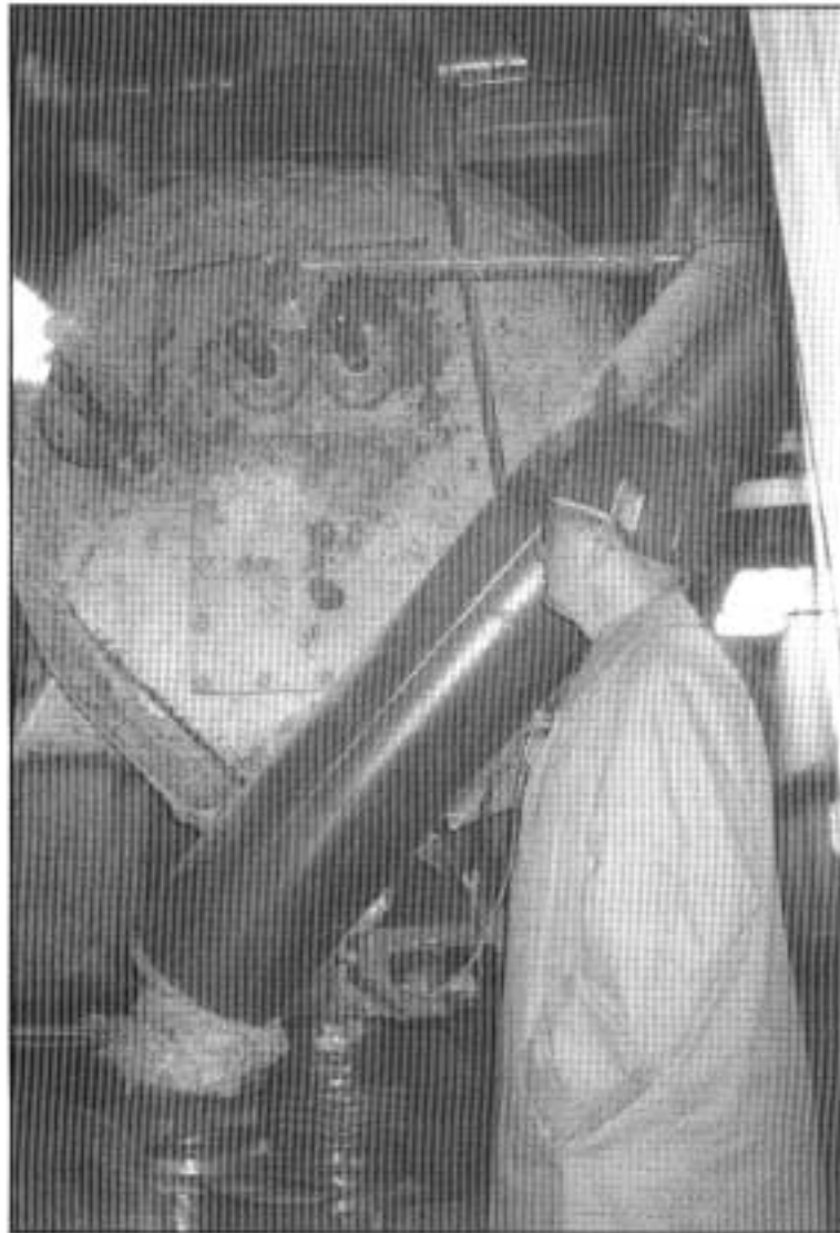
Kuva 1. Miesluukku, kuvassa 2 uusin kauimmassa päässä.
