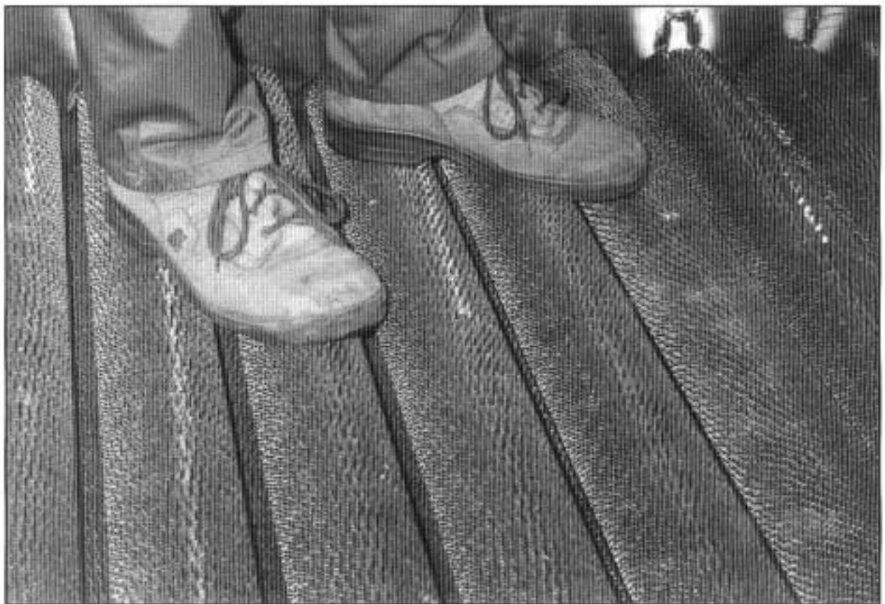
Kuva 4. Lähikuva elementin päältä.
