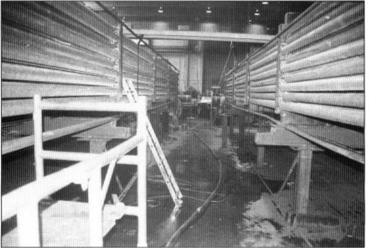
Kuva 1. Elementtien välin asennettu alumiininen ykkökusilta.
