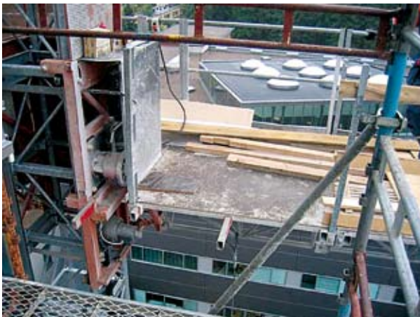
Kuva 2. Kuva julkisivutelineeltä kaiteettomasta kohdasta, johon asetettiin metalliritilät lasilankukujen siirron ajaksi.
