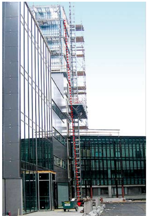
Kuva 1. Mastolava oli rakennuksen torniosan seinustalla. Julkisivuteline oli tornin vasemmalla puolella. Mastolavan laskemista rajoittava yhdyshälytys on kuvassa oikealla.
