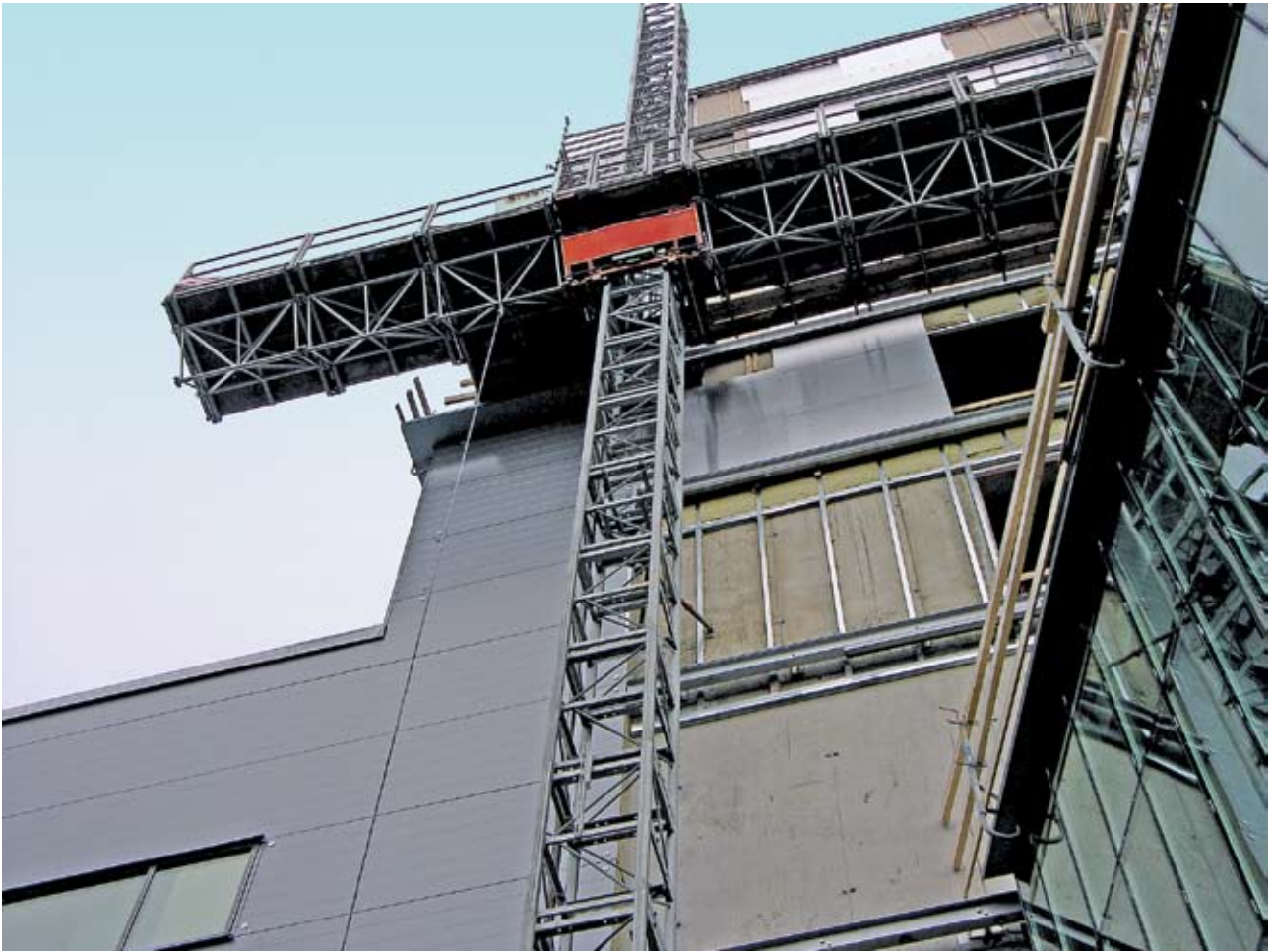
Kuva 1. Mastolava oli rakennuksen torniosan seinustalla. Julkisivuteline oli tornin vasemmalla puolella. Mastolavan laskemista rajoittava yhdyshälytys on kuvassa oikealla.
