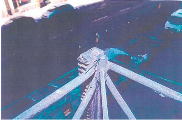
Kuva 3. Jatkokappaleen yläpää, josta näkyy, ettei kyseistä jatkokappaletta oltu pultattu missään vaiheessa ylempänä olevaan kappaleeseen. Jatkokappaleen pultinreiät olivat umpijäissä tapahtuman jälkeen.
