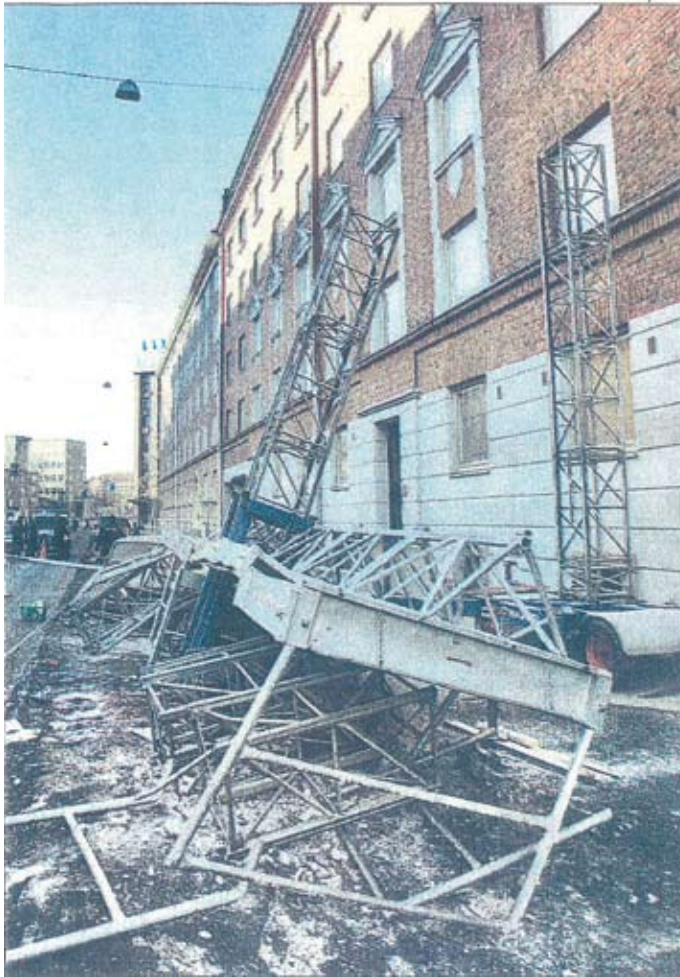
Kuva 1. Romahtaneet mastonostimen osat.
