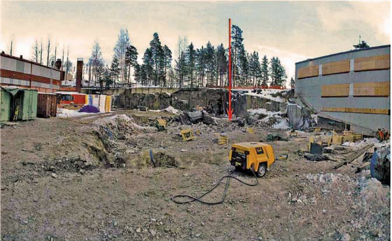
Kuva 2. Näkymä NN:n ohjaamasta kaivinkoneesta. Räjähdytyskenttä merkitty nuolella.
