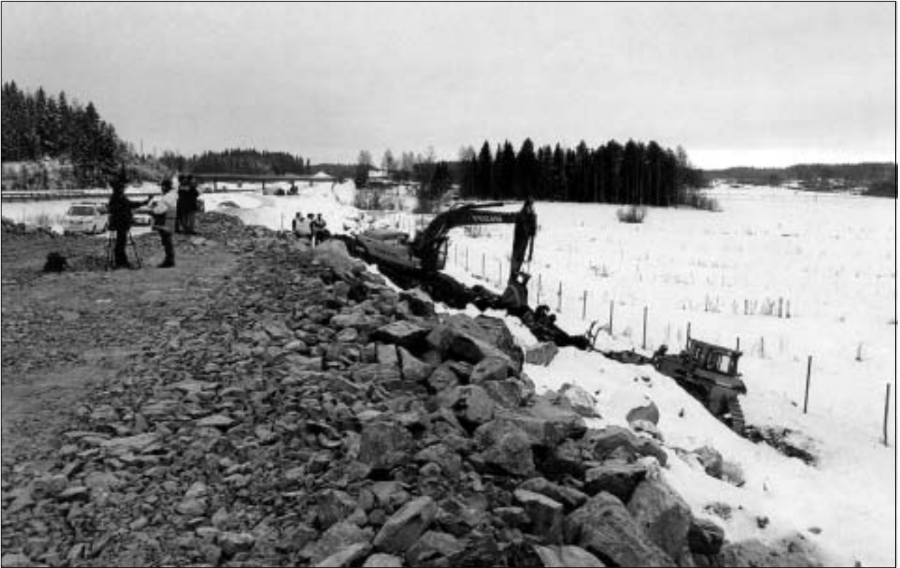
Kuva 1. Moottoritien pohja, louhetta, penkan alla pystyyn nostettu telapuskutraktori.
