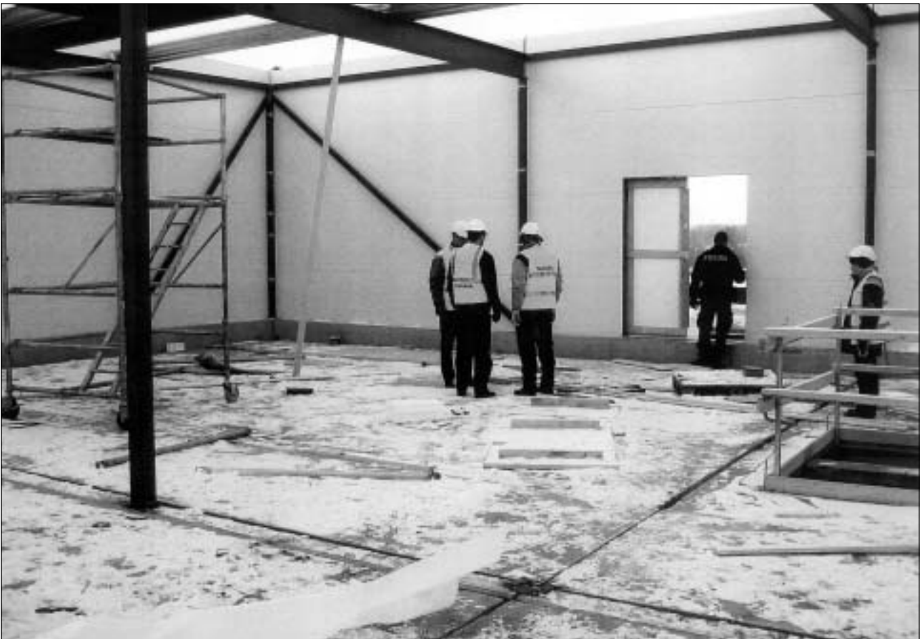
Kuva 4. Oikealla aukko suojattu kaitein.
