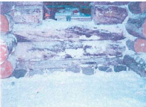
Kuva 4. Perävaunusta luistanut tukki asennettuna vaakasuoraan alimmaksi kokohirreksi.
