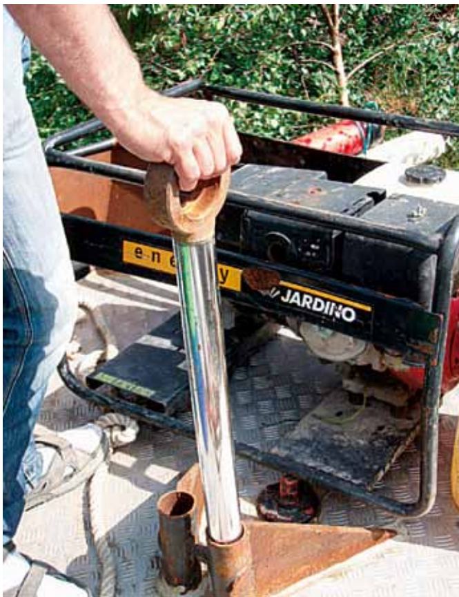
Kuva 2. Kuvassa on aluksen peräkanteen kiinnitetty tanko vetoköyettä varten ja veden pumppuun käytetty aggregaatti.
