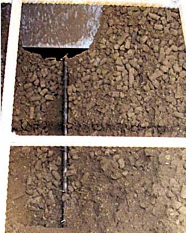
Kuva 3. Siilon pohjalla oleva syöttöruuvi ja osittain holvaantunutta palaturvetta.
