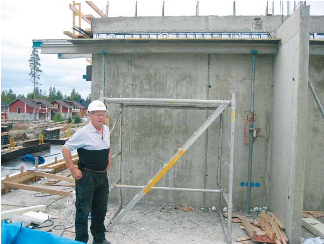
Kuva 1. Työteline, jonka päällä NN työskenteli, on kuvassa seisovan henkilön oikealla puolella.
