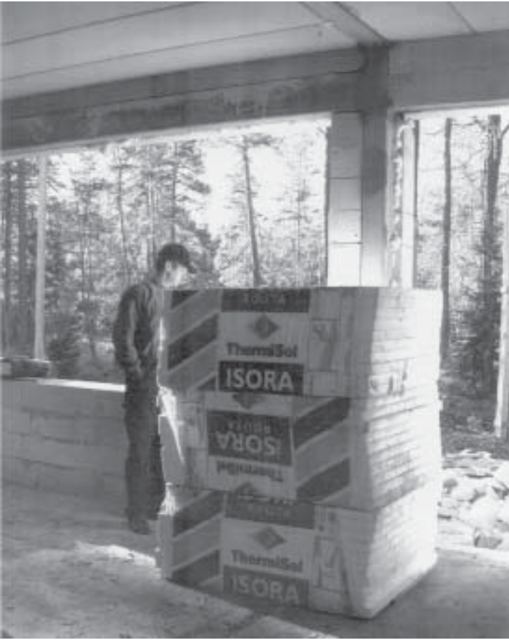
Kuva 1. Lämpöeristenippu, jota käytettiin työalustana. NN putosi ikkuna-aukon kautta.
