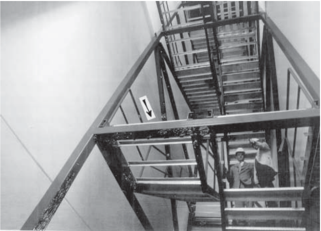
Kuva 1. Nuolella merkitty porrastaso +4,3 m sekä palkin asennuspaikka.
