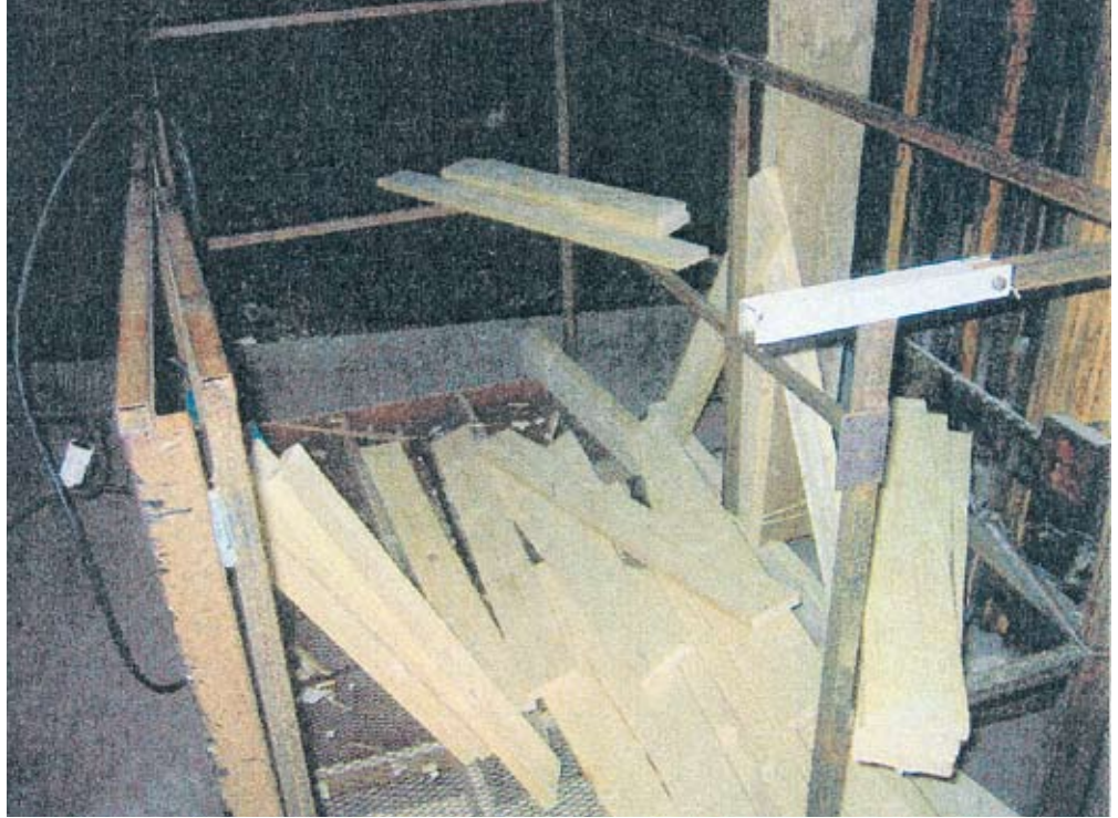
Kuva 3. Kattotuolien vahvistamiseen varattua puutavaraa.
