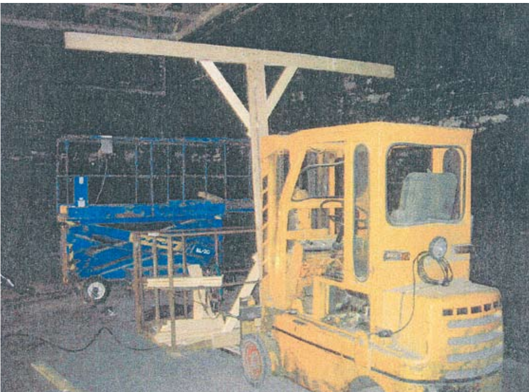
Kuva 2. Kattotuolin T-tuki.
