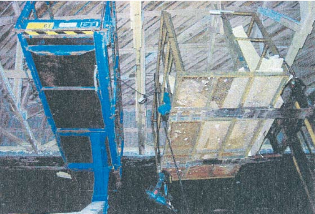
Kuva 1. Nostokorit kattotuolin molemmin puolin.
