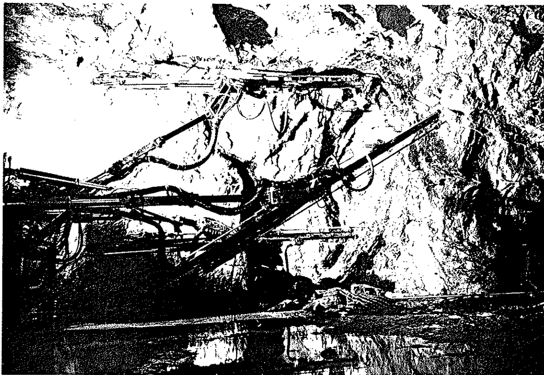
Kuva 1. Yleisnäkymä tunnelin perältä
